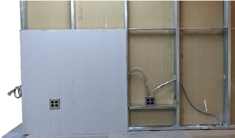
串接式牆面插座依設計規劃固定位置後，3 埠快接電纜於封牆板前，連接串接式牆面插座。
