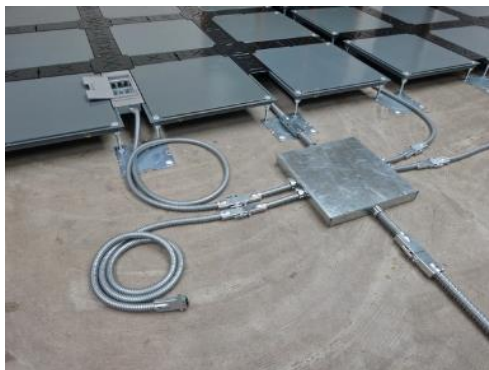
ZoneTeq MWS 安裝於網路高架地板、傳統高架地板。 .
