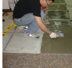
apply adhesive on par
