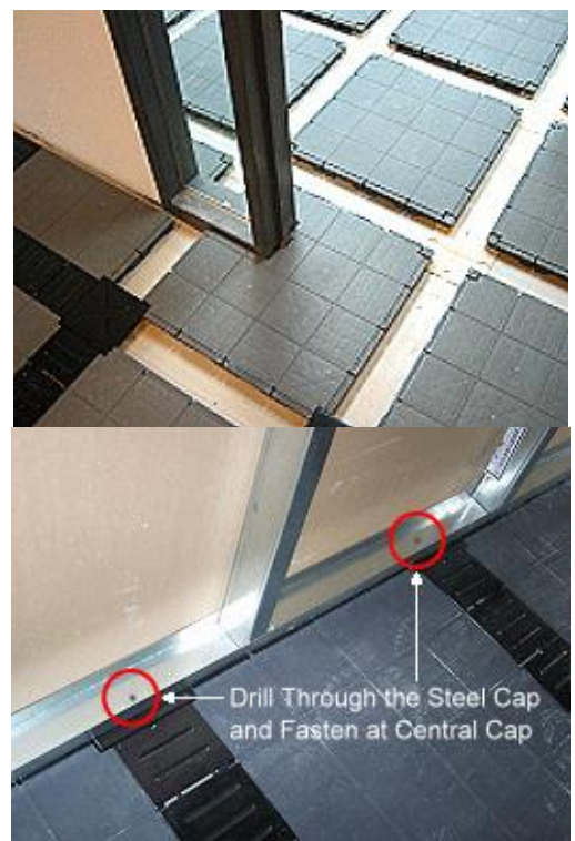
全高隔間直接安裝於網路地板上
