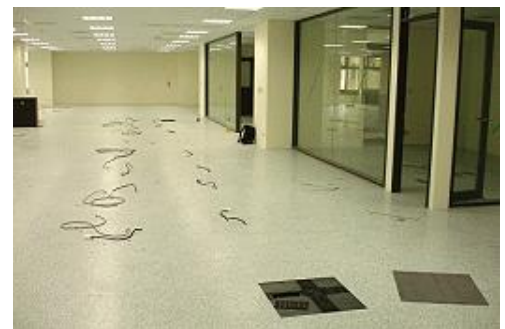
Actile 抗靜電 PVC 地磚安裝於網路地板上
