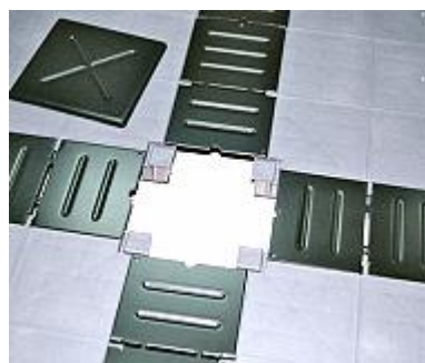
全鋼線槽架橋蓋板，安裝線槽區上保護線路，且裝、拆容易
