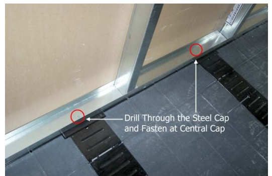
全高隔間直接安裝於網路地板上
